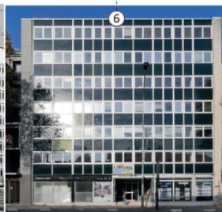
Structure béton, façades béton préfabriqué
