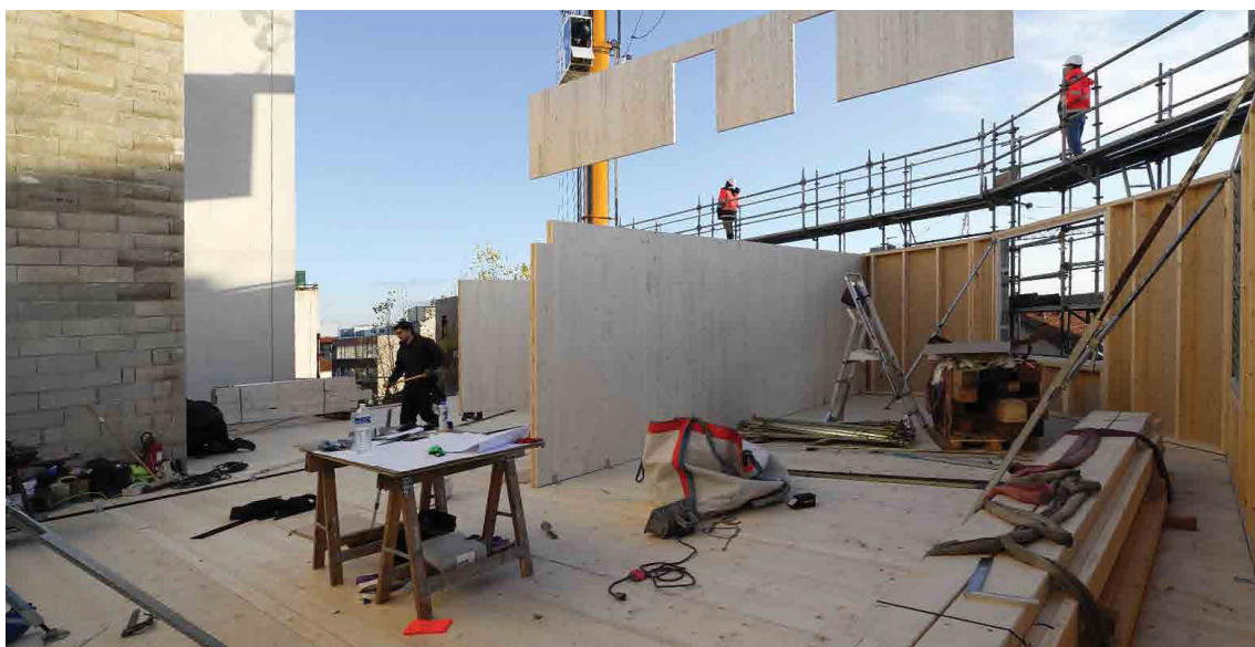
Chantier de surélévation à l'aide de panneaux de bois préfabriqués. h2o architectes
