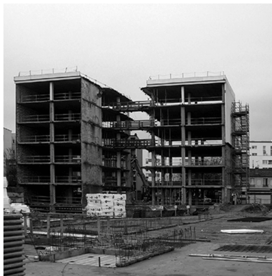
2. Noyau de circulations verticales existant. TVK
