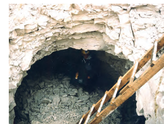
Photo cavité souterraine secteur de Châlons - source AUDC
