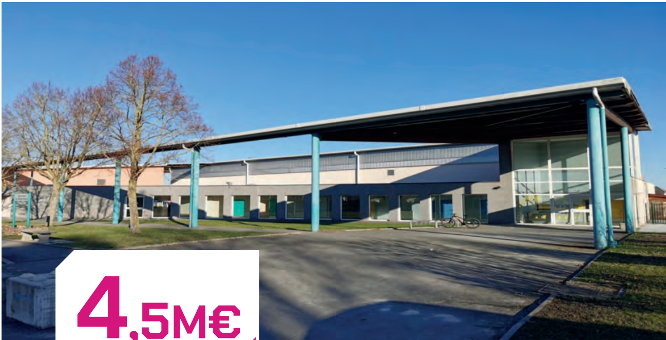
Gymnase du Terme St Hilaire Source photo : Ville de Mourmelon-le-Grand
