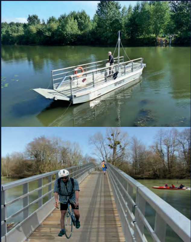
Un bac pour franchir la Marne -Source architecture navale.net Ou...une passerelle pour franchir la Marne -Source montage AUDC 2019
