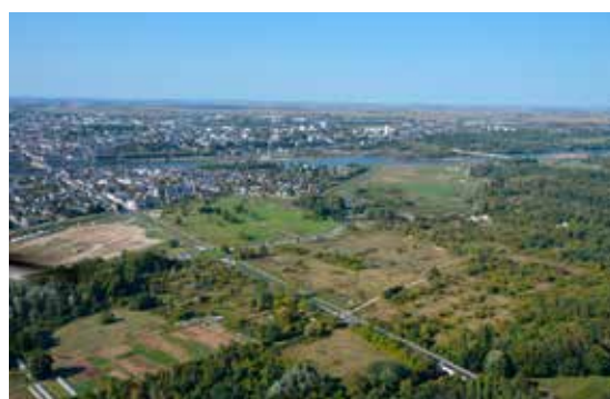
Le site de Bouillie est progressivement renaturé : les bâtiments sont démolis et les espaces artificialisés sont réaménagés afin de restaurer une zone d'expansion des crues. © AGGLOPOLYS
