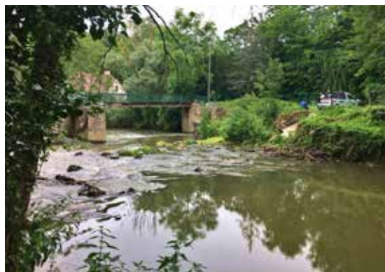
L'Yerres, 2021, suite aux travaux de suppression du barrage pour rétablir sa continuité écologique.
