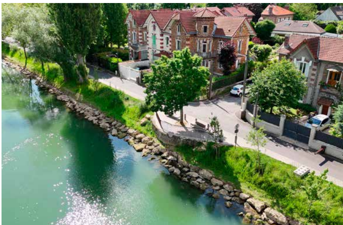
Réfection des berges par techniques mixtes, végétalisation du talus et pied de berges en enrochement. © BKM
