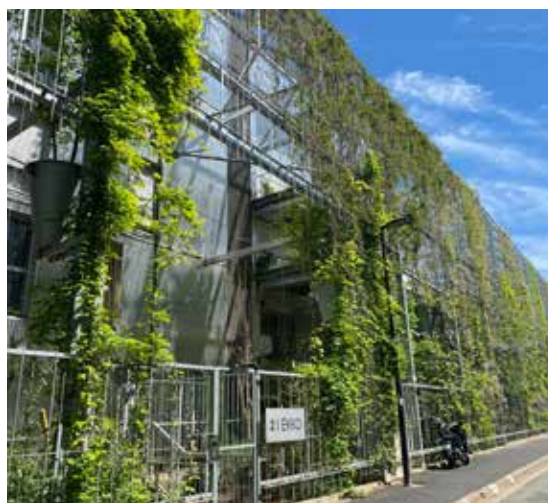
Façade réalisée en treillis métallique pour permettre sa colonisation par des plantes grimpantes (Bordeaux). © Gwendoline Grandin
