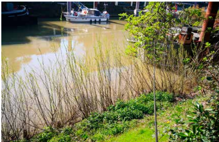
Ouvrage réalisé par l'Association Espaces en 2010 au pied du pont de Billancourt sur l'île Saint-Germain à Issy-les-Moulineaux (92). Différentes techniques issues du génie végétal ont été associées pour redynamiser la végétation et protéger durablement le talus et la berge : fascines, boutures de saules et couches de branches à rejets sous géotextile. © Association Espaces
