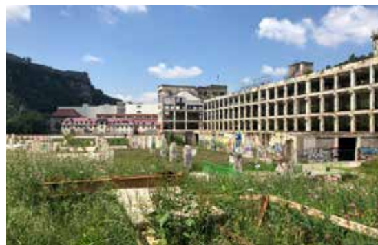
Ancienne friche industrielle des Prés de Vaux devenue le parc de la Rhodiacéta à Besançon. © STUDIO PAR ICI
