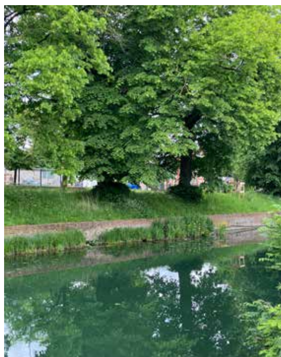
Travaux de restauration écologique des berges de la Deûle à Lille, mis en œuvre selon les principes de l'ingénierie écologique. © Gwendoline Grandin
