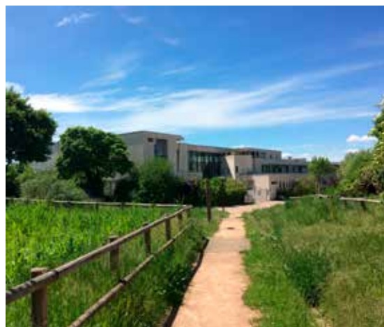
Le parc des Chênevreux, labellisé EcoJardin, combine gestion et dépollution des eaux pluviales avec le maintien d'usages récréatifs. © Arp Astrance
