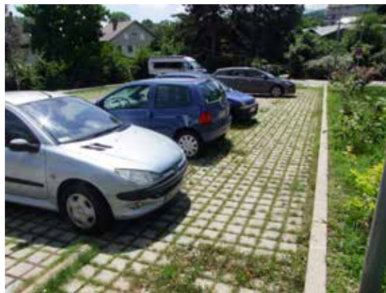
Parking perméable à La Motte-Servolex où les eaux de ruissellement excédentaires sont redirigées vers des noues. © Jonathan Flandin
