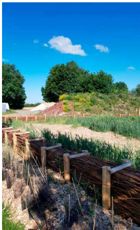
Aménagements d'hydraulique douce fascines réalisés par le Syndicat Interdépartemental du SAGE de la Nonette. © Clara Morvan – SISN
