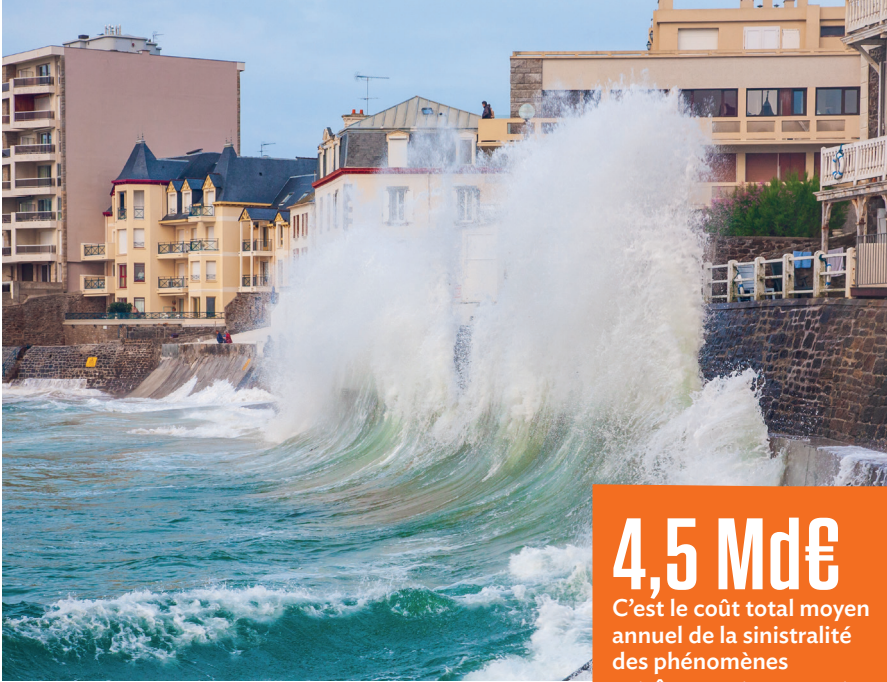
Front bâti de Saint-Malo exposé à des vagues submersives. © Willy Mobilo / iStock
