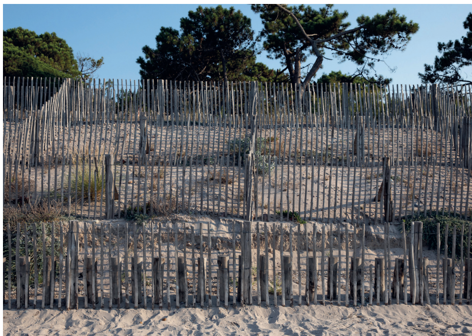
Des ganivelles installées sur les dunes littorales pour fixer le sable et limiter l'érosion côtière.
