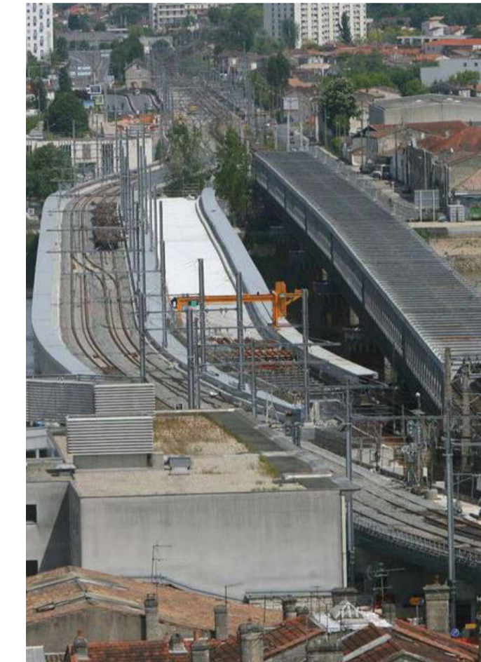
Nouveau pont ferroviaire. © Jean-Jacques Saubi, 2008
