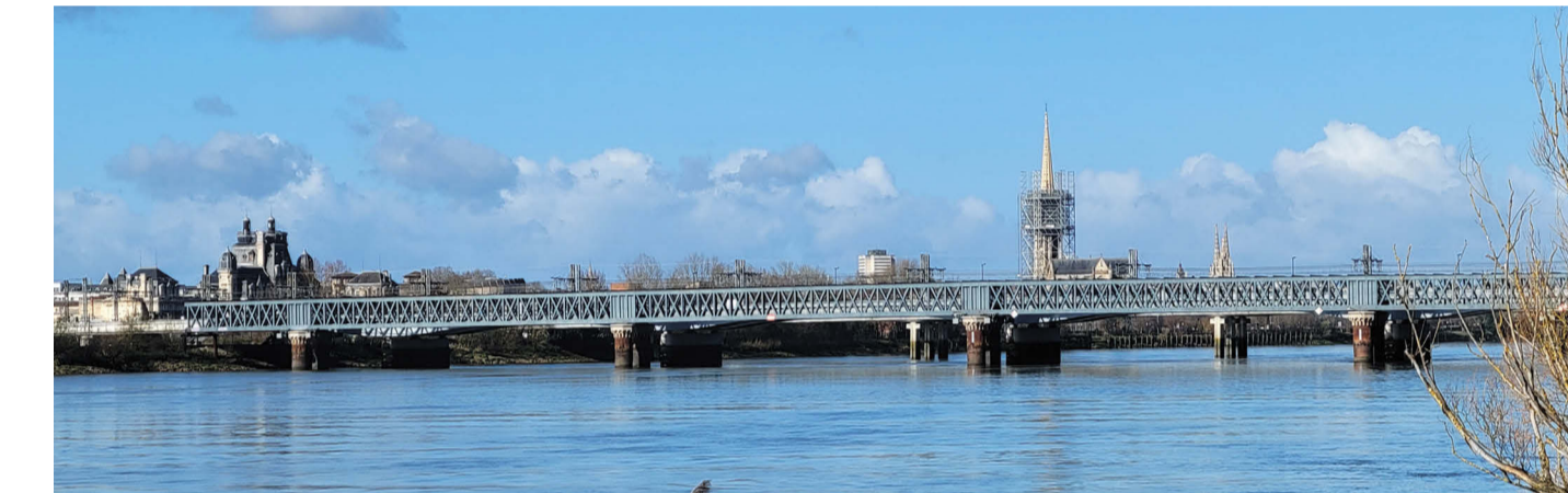
La passerelle depuis les berges de la rive droite. © David Durand, 2025
