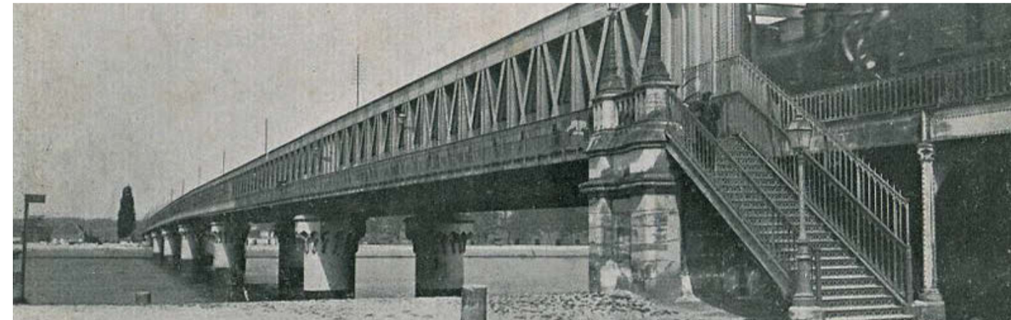
« Le pont métallique ». © Domaine public, avant 1924
