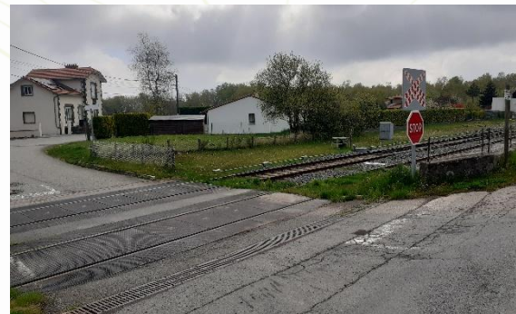
Passage à niveau non sécurisé, à l'intersection entre la rue des Besses et la rue du Pré de Jaleix
