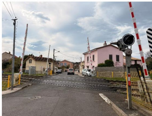
Le passage à niveau de la rue du souvenir
