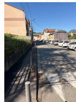
La rue du Pont Saint-Jacques présente des caractéristiques peu attractives pour les mobilités actives (idem rue de la Rotonde)
