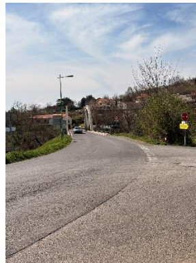
Boulevard du Pont des Goules, passage obligatoire pour rejoindre la ViaAllier depuis la gare
