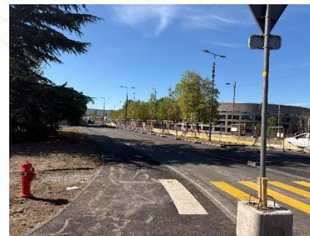
Le rond-point de La Pardieu : des travaux en cours pour l'arrivée de la ligne C d'InspiRe
