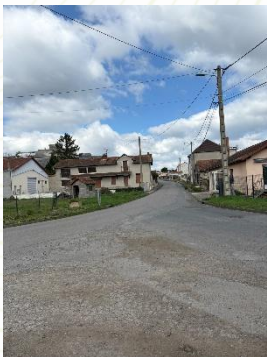
L'aménagement de la rue de la gare (vue prise au niveau de la gare) ne bénéficie pas de trottoirs
