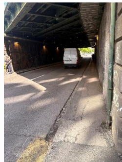
Le passage sous les voies ferrées au niveau de l'avenue Edouard Michelin : étroit et dangereux
