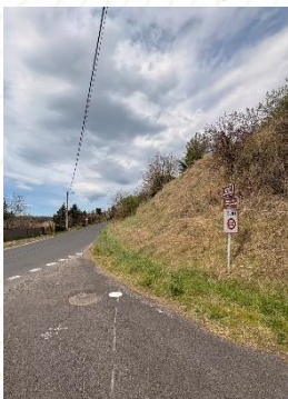
Une zone 30 ne bénéficiant d'aucun aménagement - Intersection avenue de la Libération – Route d'Yronde
