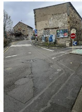
Le secteur à l'arrière de la gare (vue sur l'intersection rue de Mirefleurs / rue de la Garenne) peu propice aux mobilités actives
