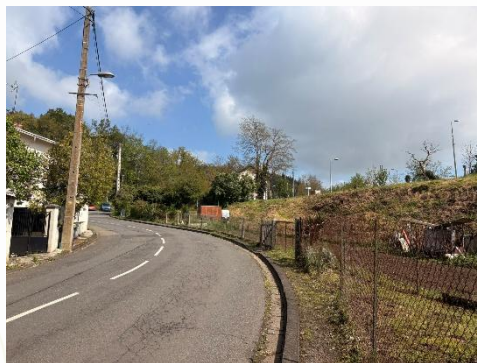
La rue de la gare, reliant la gare au centre-ville ne dispose pas de trottoirs
