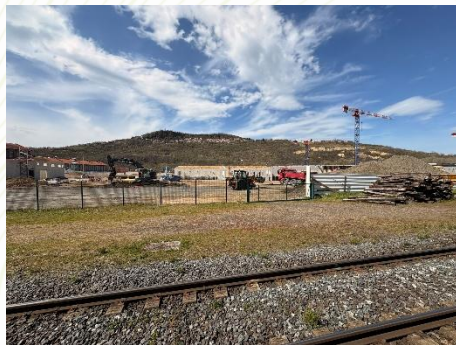
Le chantier du nouveau site industriel, juste derrière la gare, mais sans accès direct
