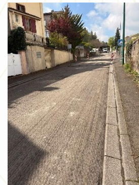
Aménagement de la rue Pasteur (en travaux – avril 2025)
