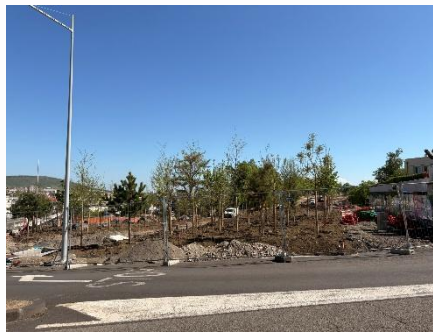
Les travaux de réalisation du futur parc de Saint-Jacques (Parc de la Muraille), au niveau du viaduc
