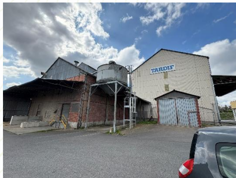
Zone industrielle à proximité de la gare
