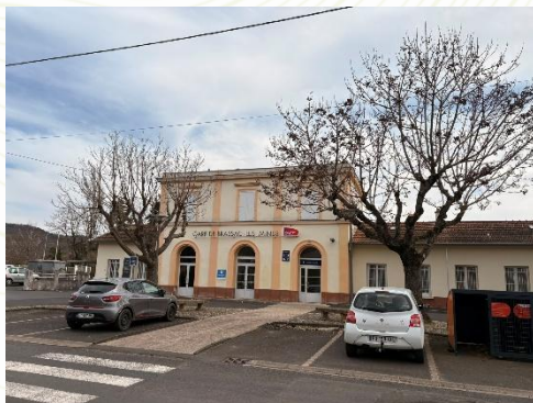
Bâtiment gare de Brassac-les-Mines
