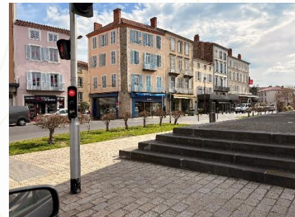
Un centre-ville bénéficiant d'aménagements plutôt qualitatifs
