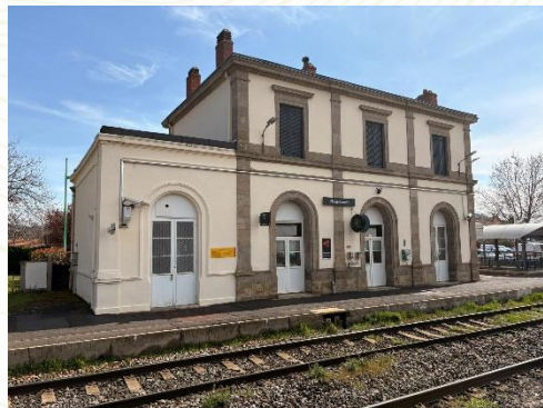
Bâtiment gare de Vic-le-Comte
