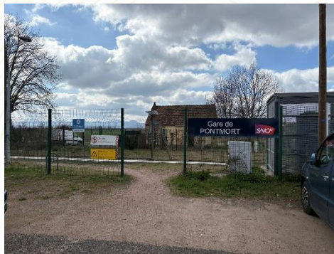
Une gare dotée d'un unique quai, accessible directement depuis le parking
