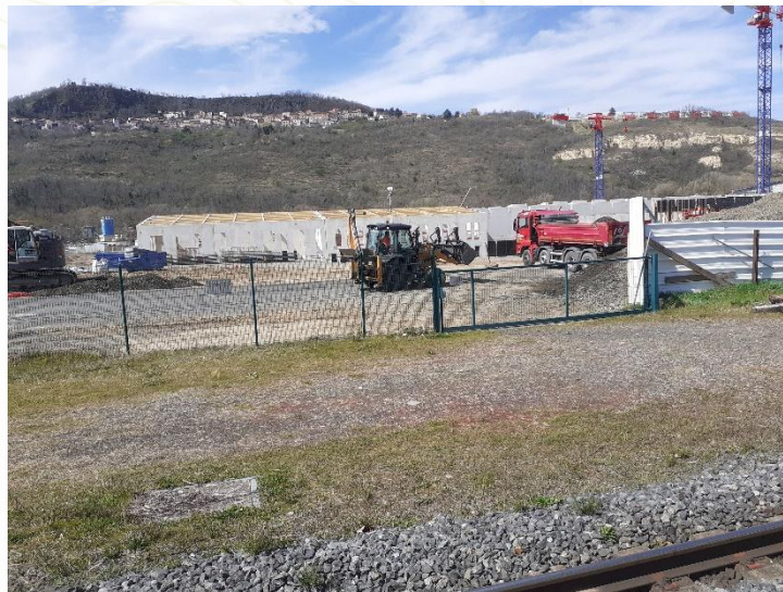
Le chantier de la Banque de France à proximité de la gare de Vic-le-Comte
