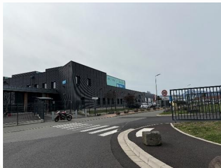
Le lycée Roger Claustres reste relativement inaccessible, malgré sa proximité de la gare et de l'aéroport
