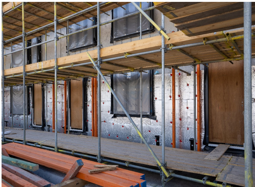
⇒ Isolation extérieure d'un bâtiment d'habitation © Éric Mclean
