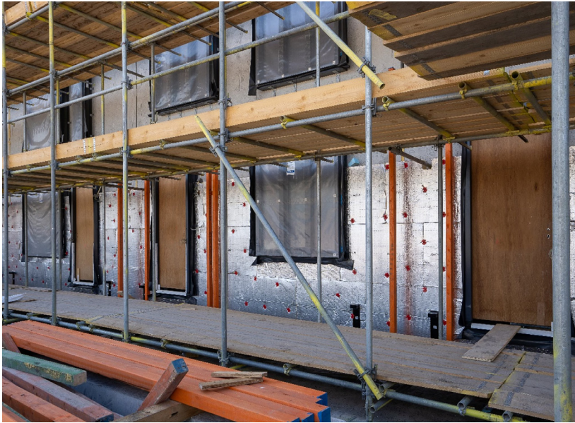
⇒ Isolation extérieure d'un bâtiment d'habitation © Éric Mclean
