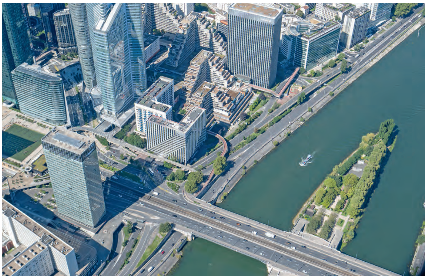
Le quartier de la Défense concentre d'importantes surfaces de bureaux qui produisent des volumes élevés de déchets papiers et cartons
