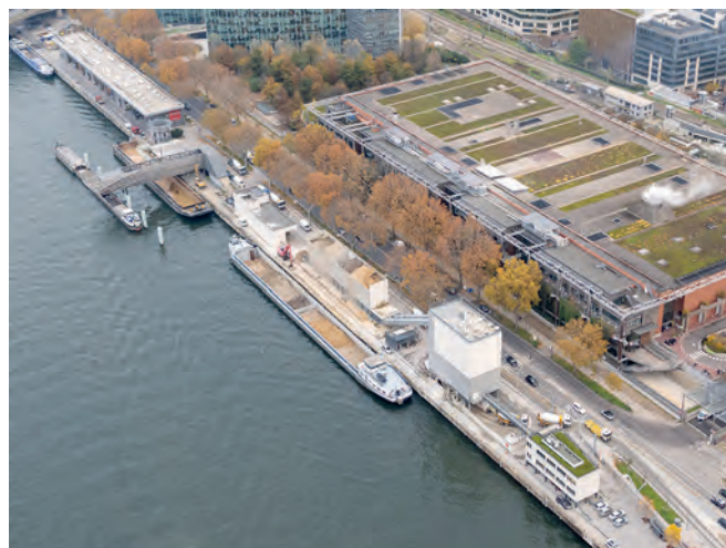
Centre de traitement Isséane à Issy-les-Moulineaux (Syctom)
