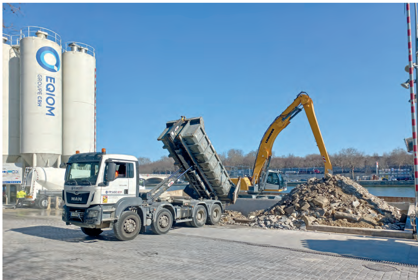
Chargement de déchets inertes sur le quai d'Eqiom au port de Tolbiac - Paris 13°
