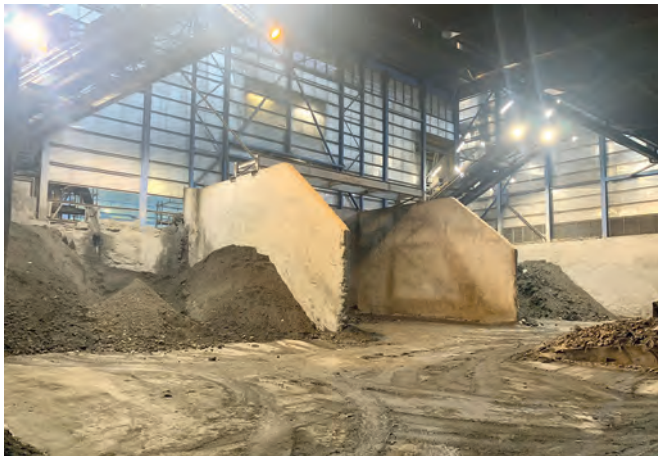
Mâchefers dans l'Unité d'Incinération des Ordures Ménagères (UIOM) d'Ivry-sur-Seine
