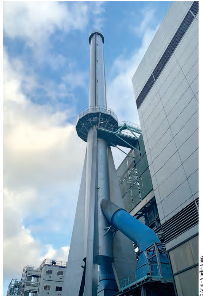
Actuelle UIOM d'Ivry-sur-Seine qui sera remplacée courant 2025 par un nouveau site, dont la capacité annuelle de traitement sera divisée par 2
