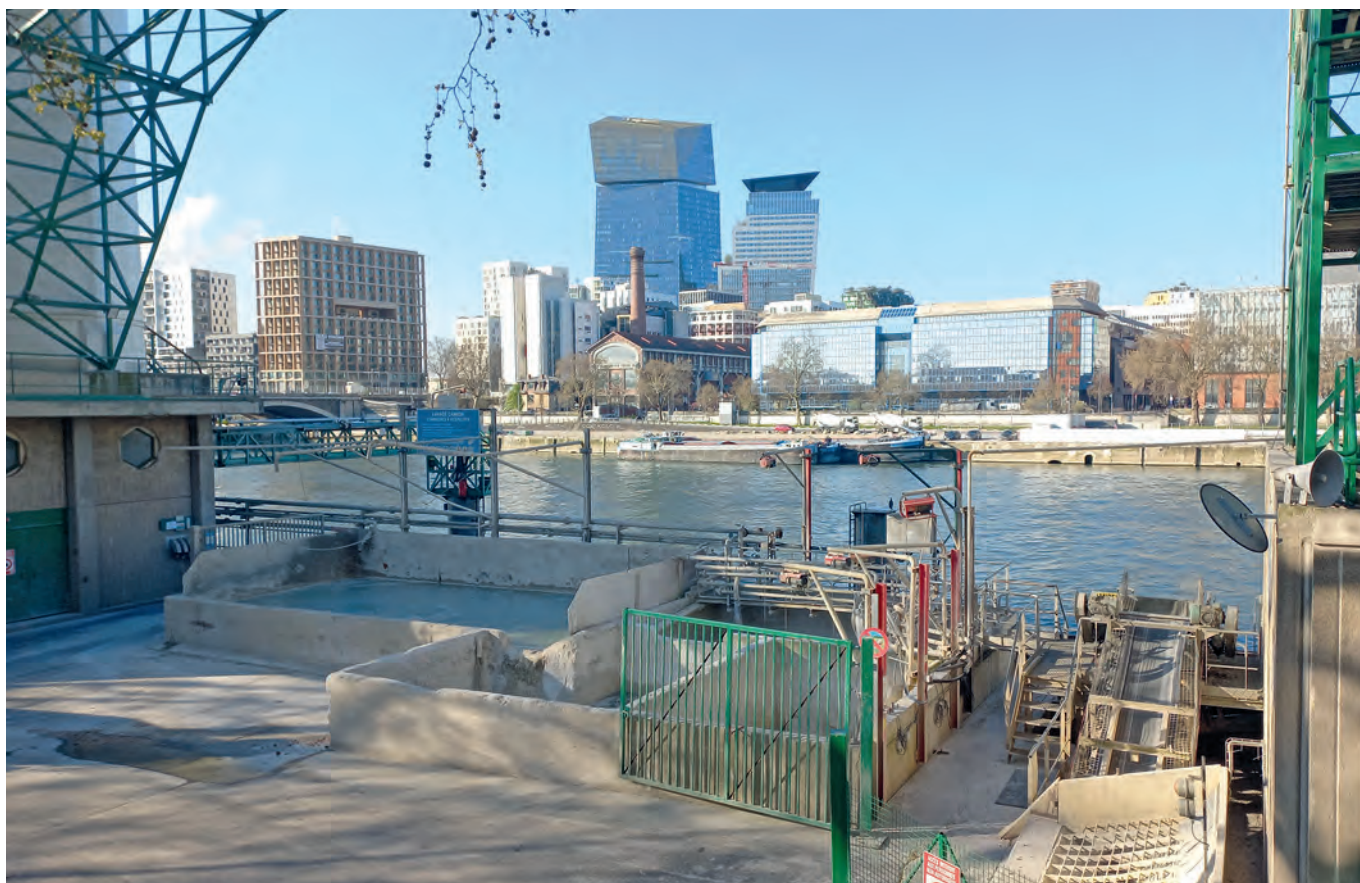
Site Lafarge sur le Port de Bercy - Paris 12 e
