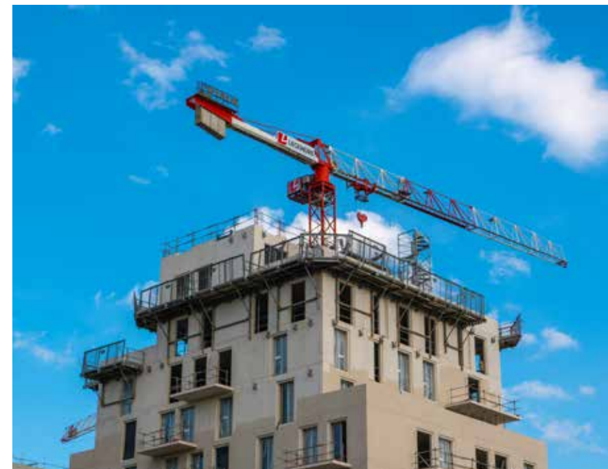
Construction d'un immeuble de logements à Nantes. © Gab Audiovisuel / Unsplash
