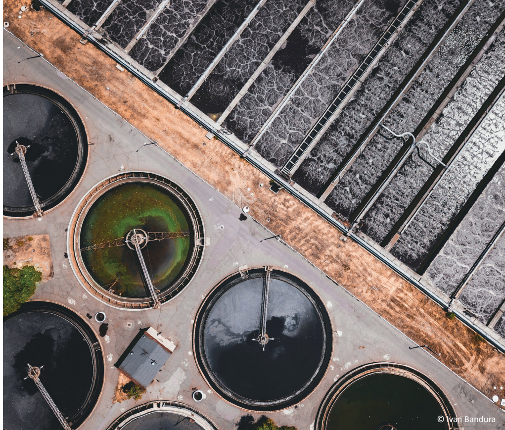
Station d'épuration des eaux usées
