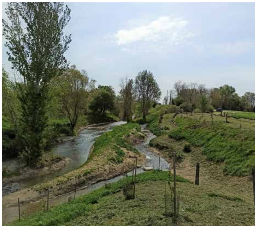
Confluence Hers-Maury (après travaux 2021)
