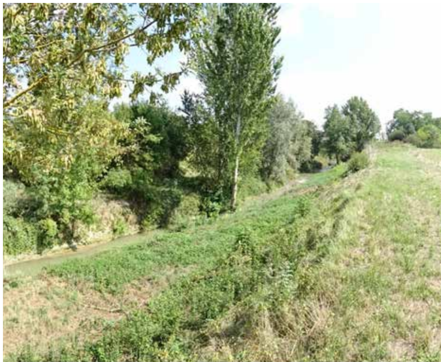
Confluence Hers-Maury (avant travaux 2018)
