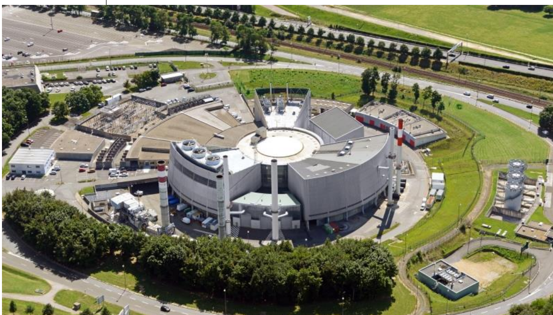
Centrale thermo-frigo-électrique (CTFE) du groupe ADP injectant la chaleur produite par ses installations dans le réseau ADP Source : Groupe ADP
