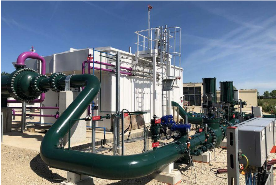
Site pilote Tenore à Villiers-le-Bel pour récupérer l'énergie fatale produite lors des opérations de détente du gaz. Source : GRTgaz
