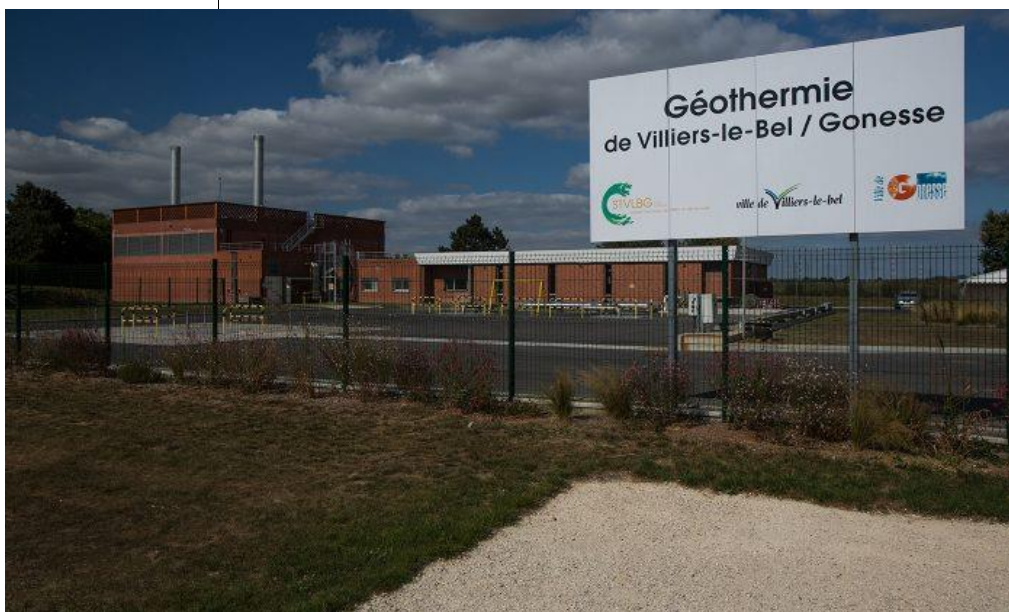
Site de la centrale et des forages géothermiques injectant dans le réseau de chaleur de Villiers-le-Bel Gonesse Source : STVLBG
