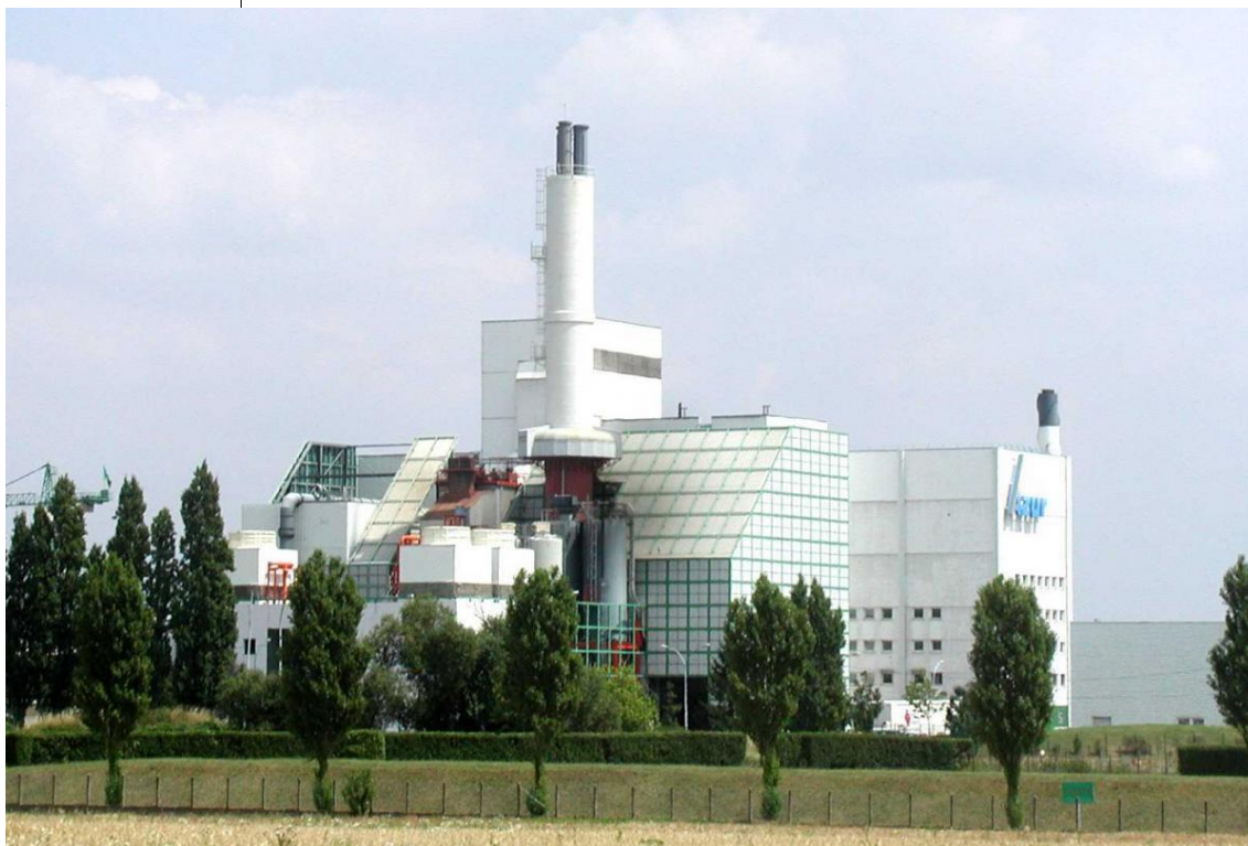
Usine d'incinération des déchets ménagers et assimilés d'Argenteuil valorisant sa chaleur dans le réseau de la ville Source : Syndicat Azur
