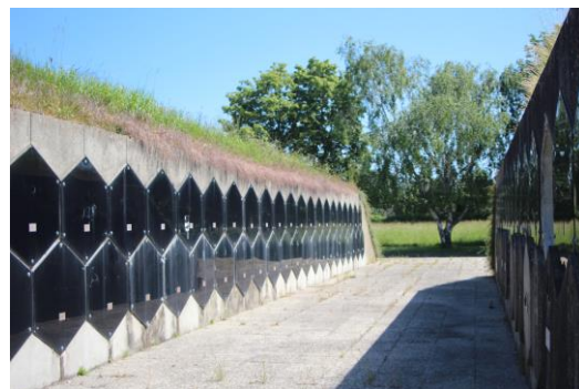
Allées d'enfeus couvertes de végétation, camouflant les cheminées d'aération
