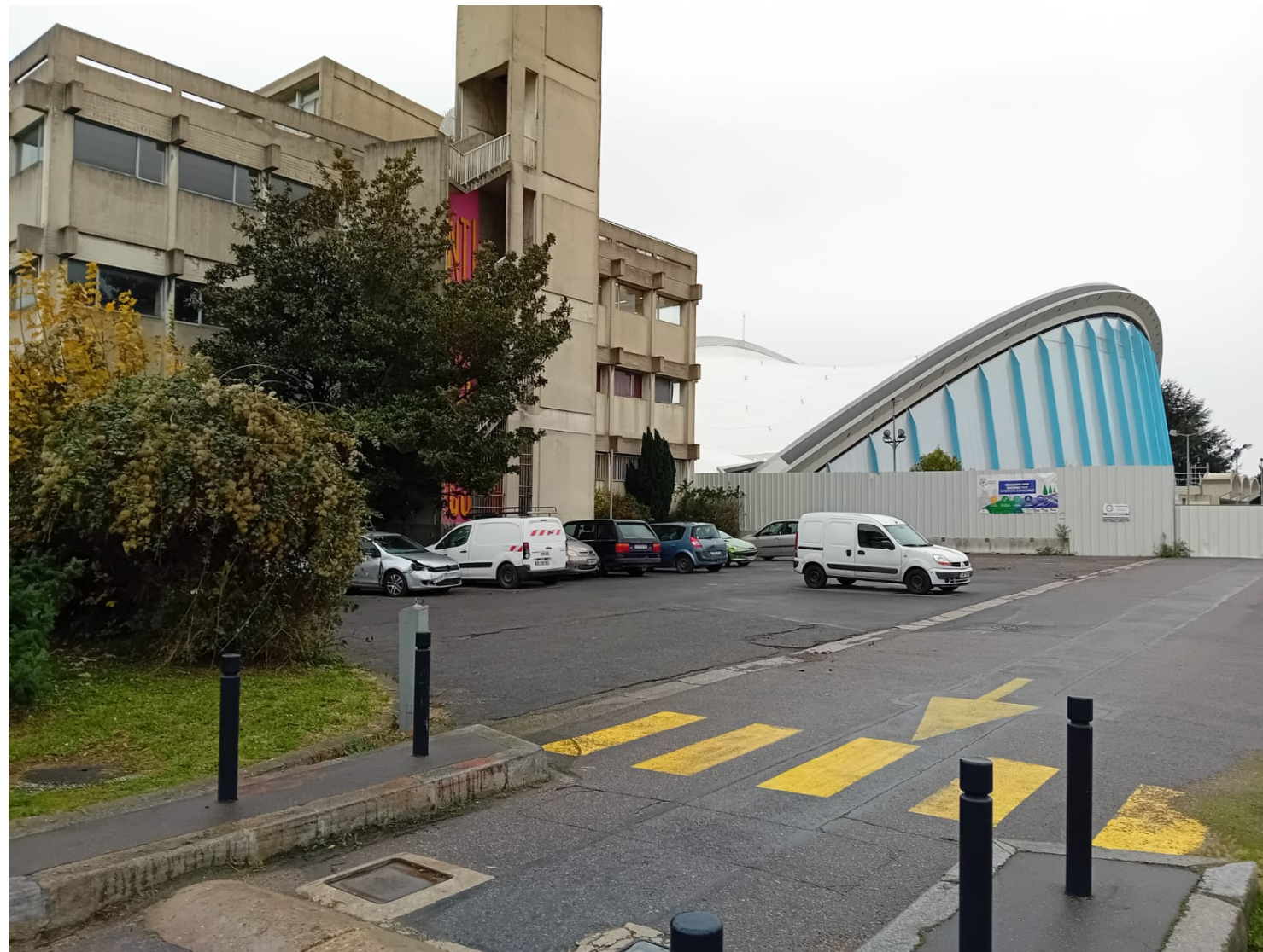
Grande Nef en cours de réhabilitation pour les Jeux Olympiques de 2024
