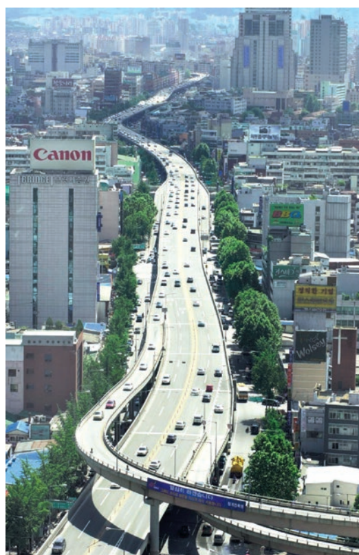
Avant : la Cheonggyecheon Expressway, crédit : Seoul Metropolitan Government
