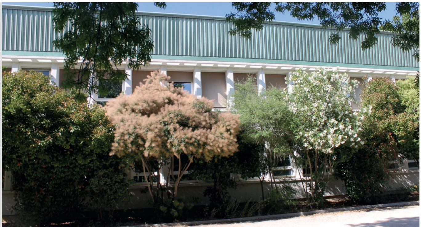
Haie de végétaux ayant une fonction rafraichissante et d'ombrage pour les bureaux. Les essences se sont adaptées, sans arrosage, à un climat sec et chaud - Crédits INRAE
