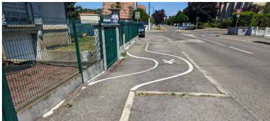
Rue de l'étang – Marquage au sol « sinueux »
