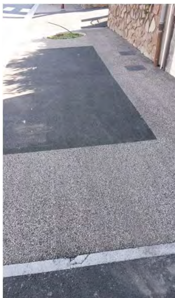
Grenailage localisé (Source Servanet)
