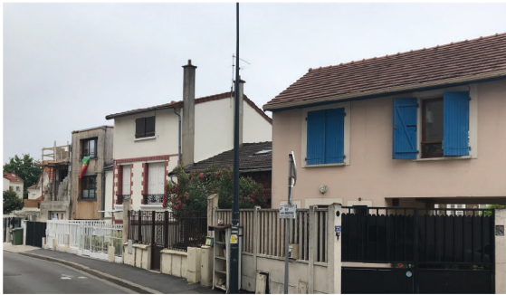
Densification douce d'habitat individuel à Fontenay-sous-Bois
