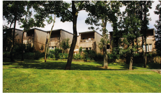
Programme de logements HLM intermédiaires à Ormesson-sur-Marne
