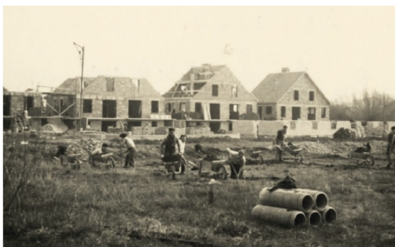
Cité Castors en construction à Antony
