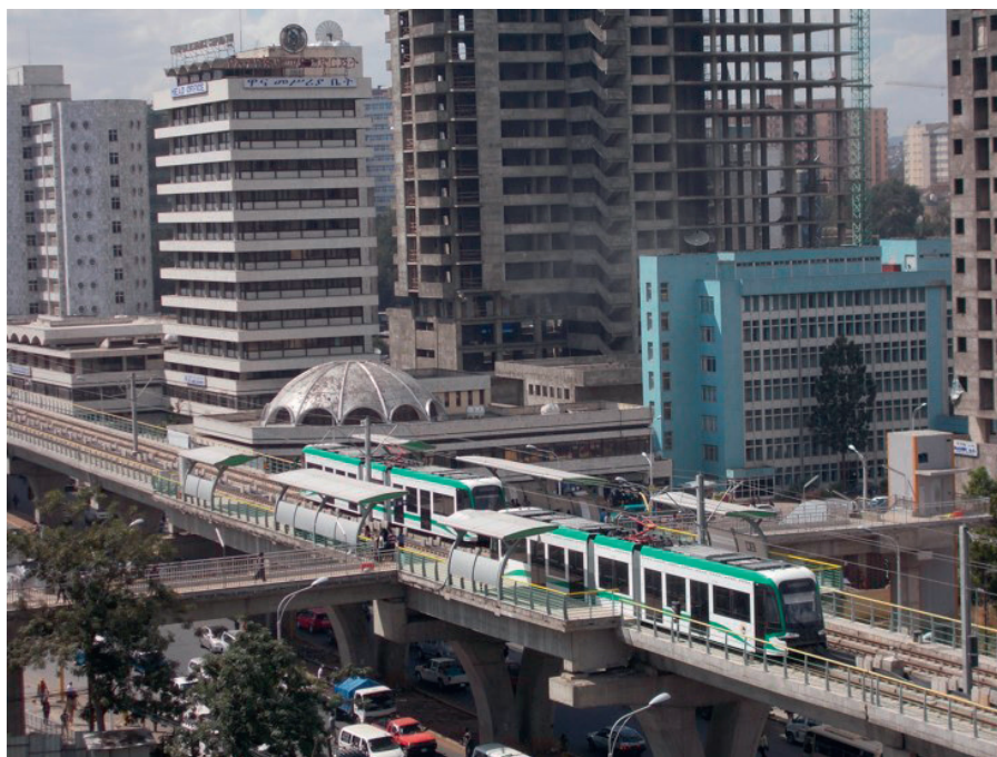
Le LRT (light rail transit) mis en service fin 2015 © URBALYON
